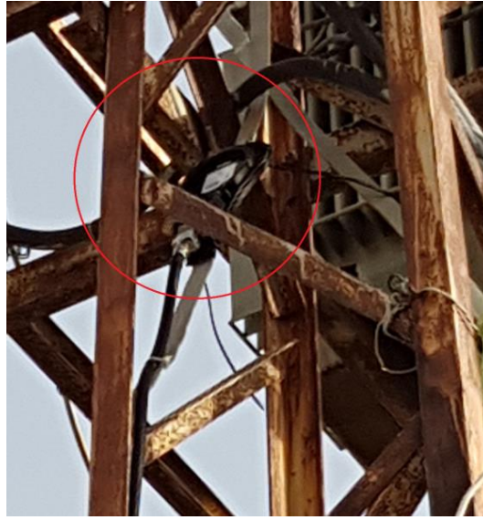
Şekil 2 Yıldırım Akımı Sensörünün İniş İletkenine Konumlandırılması
