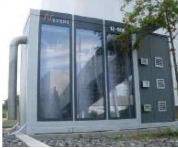
Şekil 3 Süper iletken arıza akımı limitleyici uygulaması
